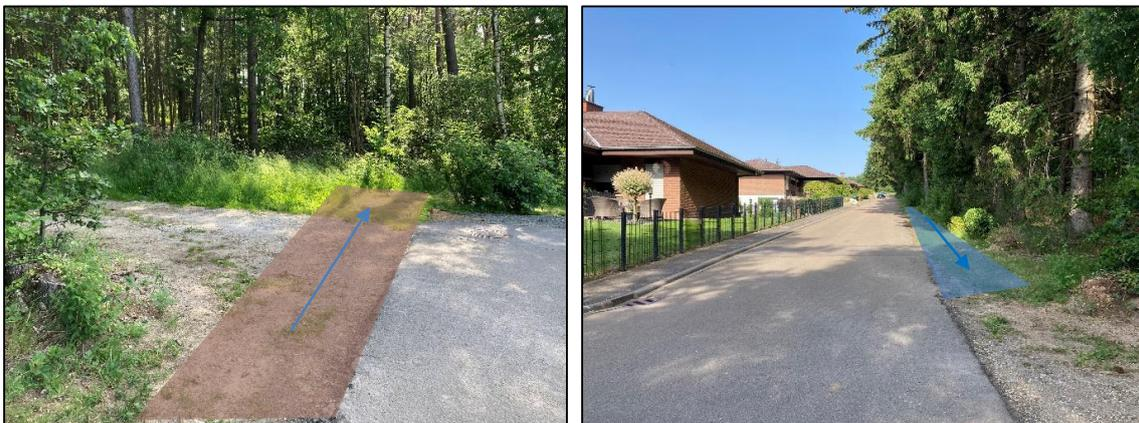
Abbildung 30: Querrinne zur Ableitung des Wassers in Richtung Wald (links) und Mulde (rechts)
