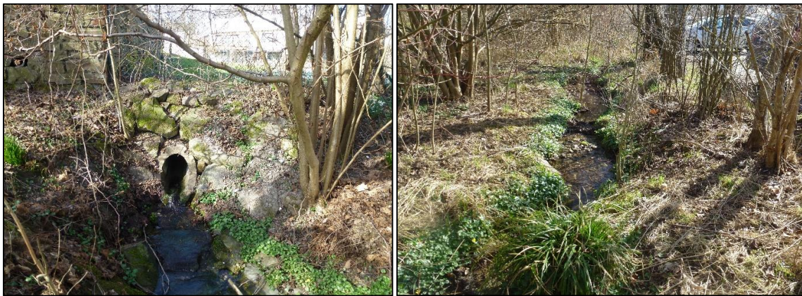
Abbildung 79: Beginn des offenen Grabens im Bereich des Parkplatzes
