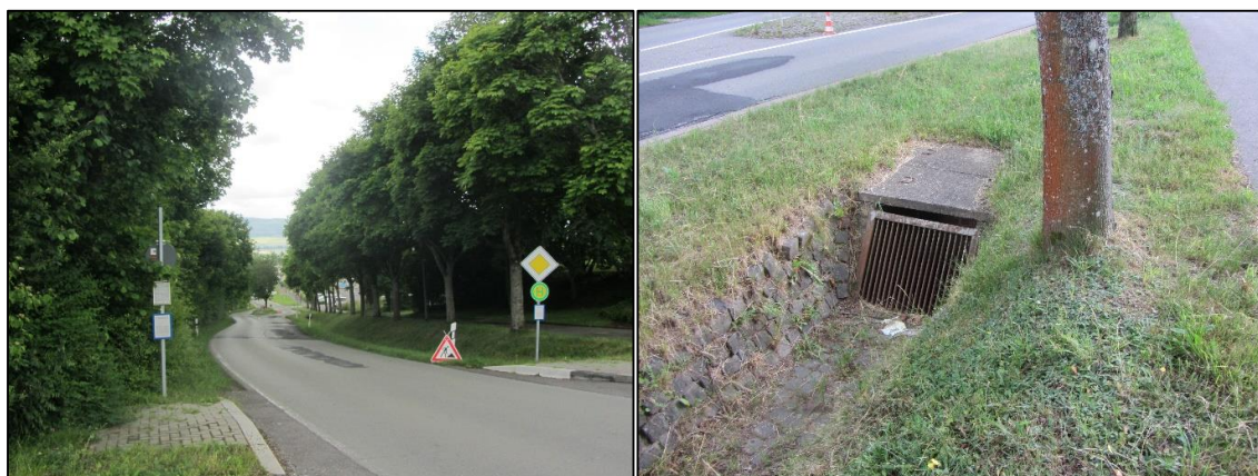
Abbildung 70: Entwässerungsgraben der Hauptstraße
