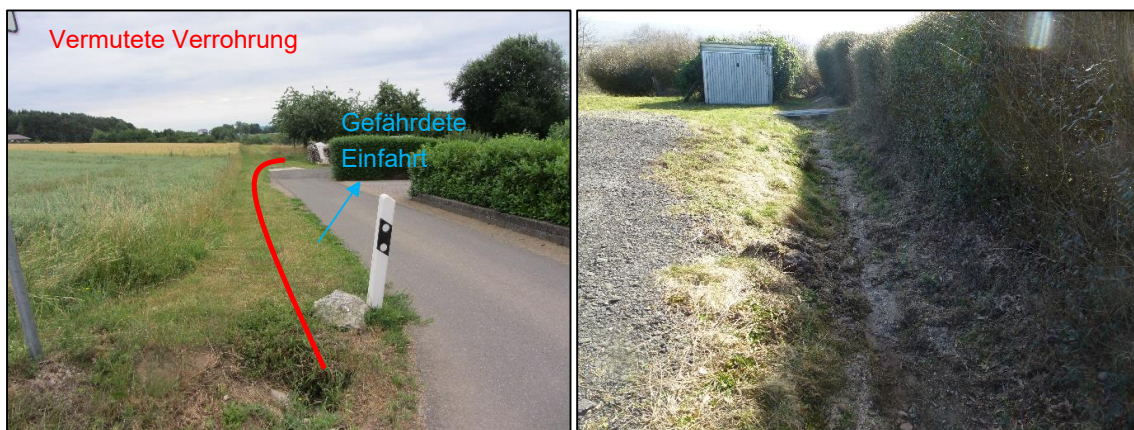
Abbildung 48: Verrohrung (links) sowie Beginn des Gewässers (rechts)
