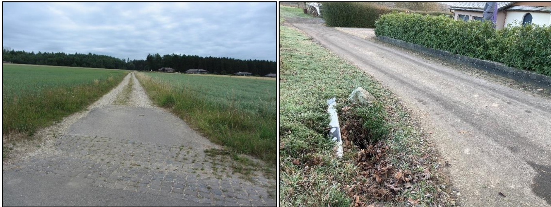
Abbildung 47: Gepflasterte Querrinne (links) und Beginn der Verrohrung (rechts)
