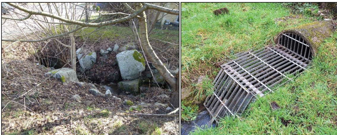
Abbildung 56: Durchlass "Zehnrech" (links) mit Beispielbauwerk (rechts)
