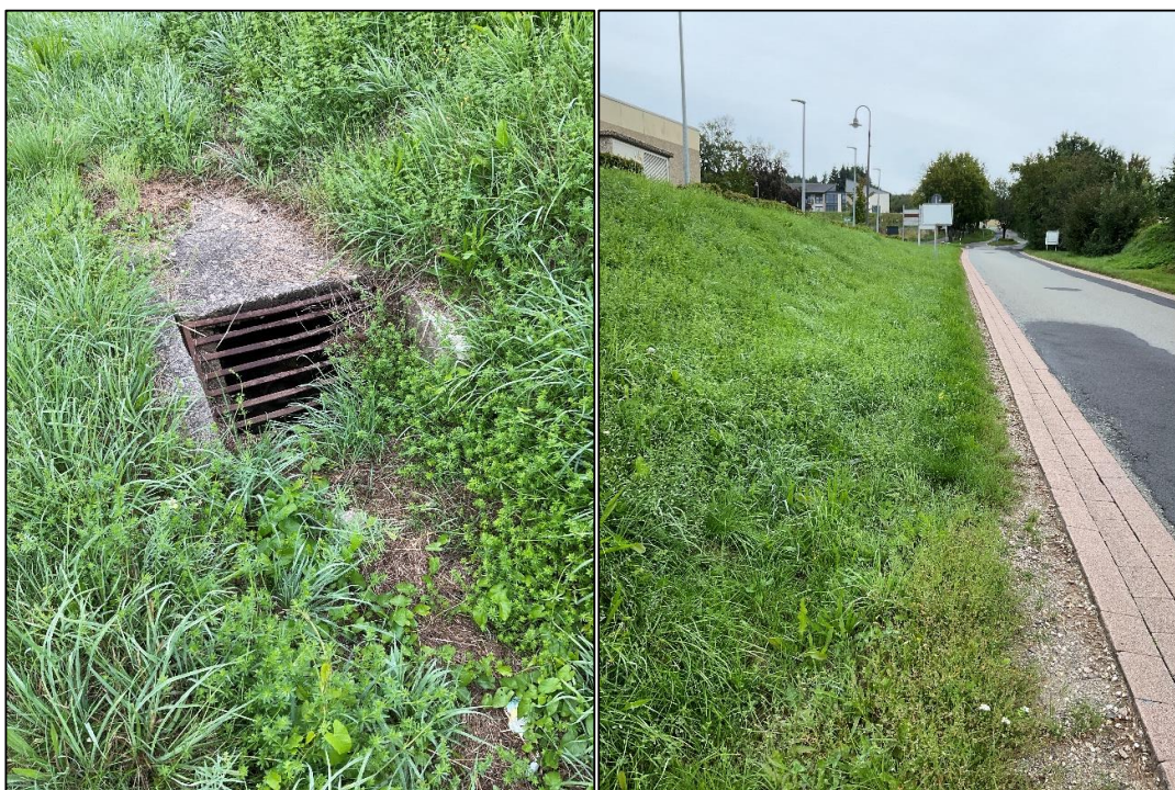
Abbildung 72: Einlaufbauwerk am Straßenrand der Hauptstraße (links) mit Blick auf den nicht ausgeprägten Straßengraben (rechts)
