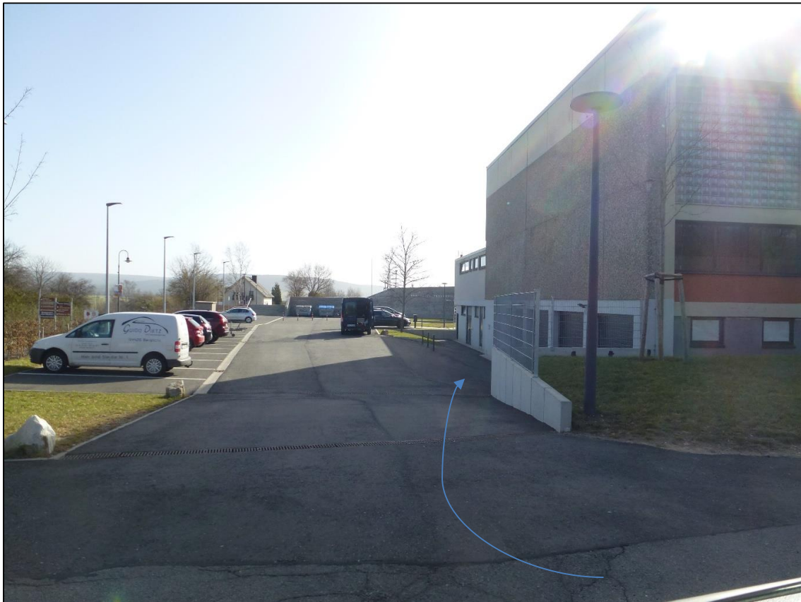
Abbildung 60: Tiefere liegende Gebäudeöffnungen an der Schule
