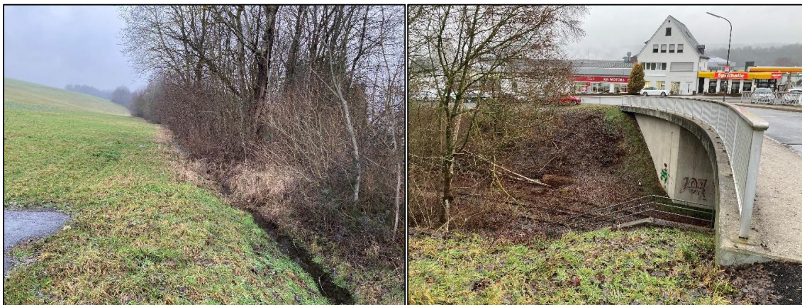
Abbildung 92: Entwässerungsgraben oberhalb der Bahngleise (links), Bahngleise in tiefem Graben (rechts)
