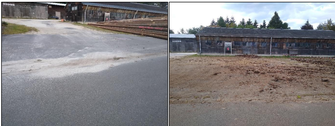
Abbildung 104: Verschmutzte Entwässerungsrinne im Bereich des Bauhofes (Fotos: Kopper, 2020)
