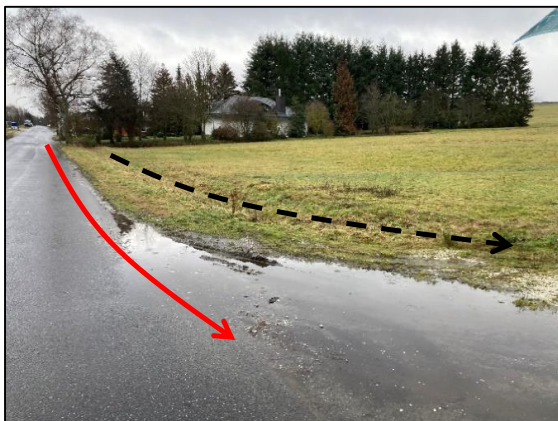
Abbildung 108: Niederschlagswasser fließt nicht in die Entwässerungsmulde
