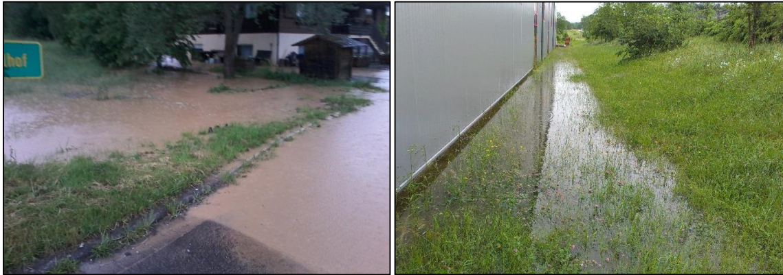
Abbildung 103: Aufstau des Außengebietswassers am Einlaufbauwerk (links) und Überflutung des Grundstückes Hsnr. 2 (rechts) (Kopper, 2018 (links) und 2013 (rechts))
