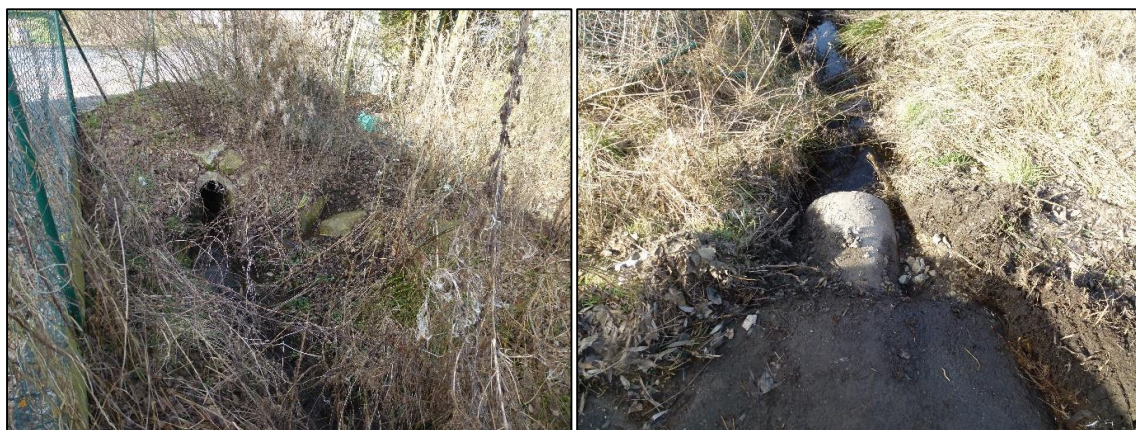
Abbildung 93: Durchlässe im Bereich des Seniorenheimes - unten links: Straßendurchlass Charlottenhöhe
