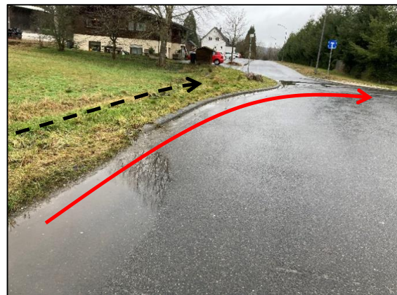
Abbildung 108: Niederschlagswasser fließt nicht in die Entwässerungsmulde
