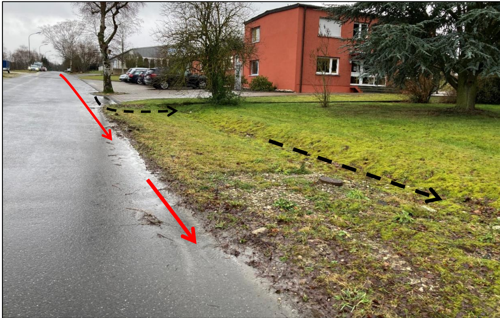
Abbildung 107: Vorhandener Abschlag in die Raubettmulde
