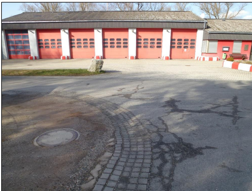
Abbildung 95: Frontale Ansicht des Feuerwehrgerätehauses
